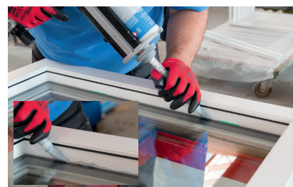
Sponning vullen met lijm
